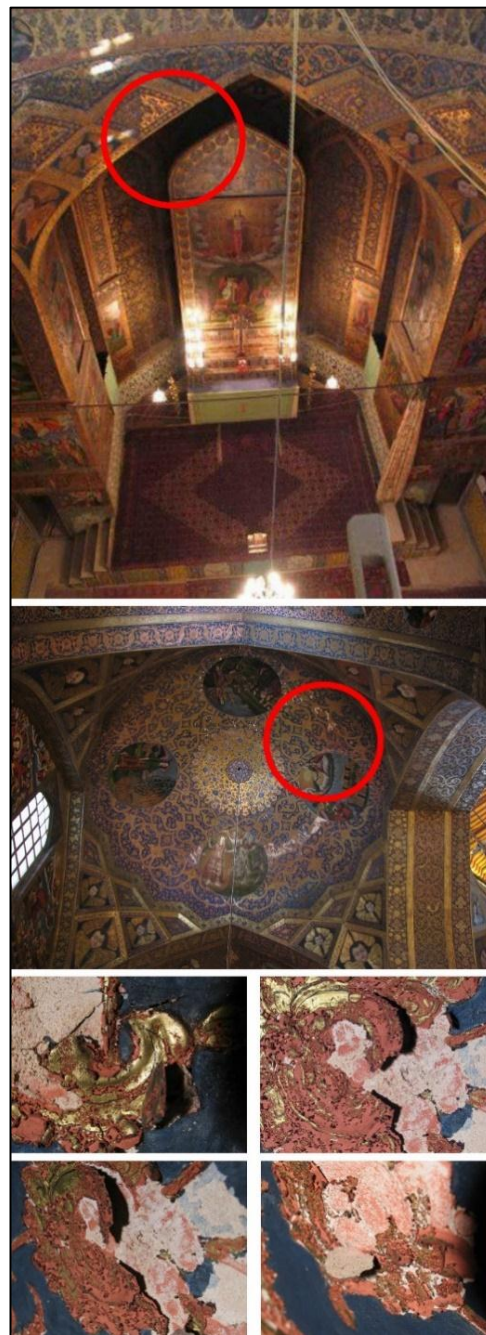
شکل ۲: مجموعه تصاویر کلیسای وانک. تصویر بالا: محل نمونه‌برداری نمونه‌ی 2010.V.1، تصویر وسط: محل نمونه‌برداری نمونه‌ی 2009.V.2، چهار تصویر پائینی، لایه‌چینی‌های آسیب‌دیده‌ی قبل مرمت.
