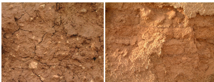
شکل ۴: خشت‌های ناهمگن و همراه با خرده آجر
