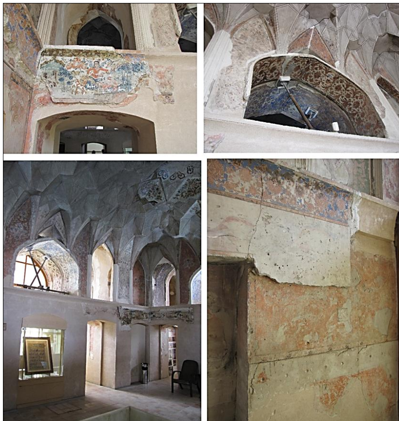
شکل ۲: لایه‌چینی و طلاکاری در لایه‌های مختلف آرایه معماری در عمارت چهل‌ستون قزوین Fig. 2: Pastiglia and gilding in different layers of architectural arrangement in Qazvin chehelsotoun
